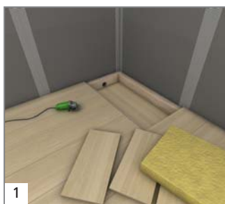
1 Découper le plancher bois aux dimensions du receveur et ôter l'isolant se trouvant en dessous.
