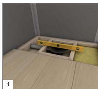
3 ... et contrôler le positionnement de l'écoulement.
